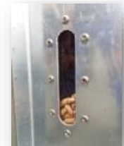
Jauges de remplissage en façade.
